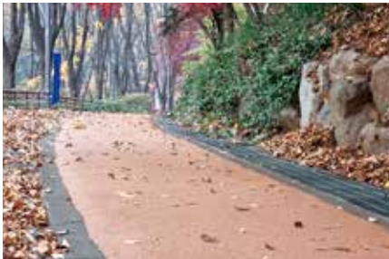
서대문 안산 자락길-코르크 맨발길 ( '21년 11월 시공)
